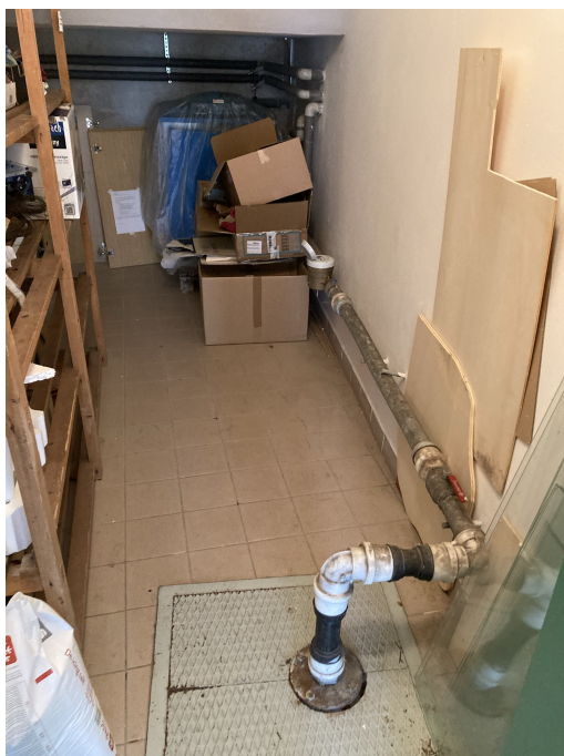
Stávající vodovodní přípojka a vodoměr uvnitř objektu.
